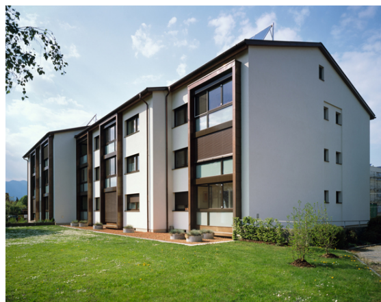
Obrázek: Obytný dům Rankweil-Schleipfweg po obnově
